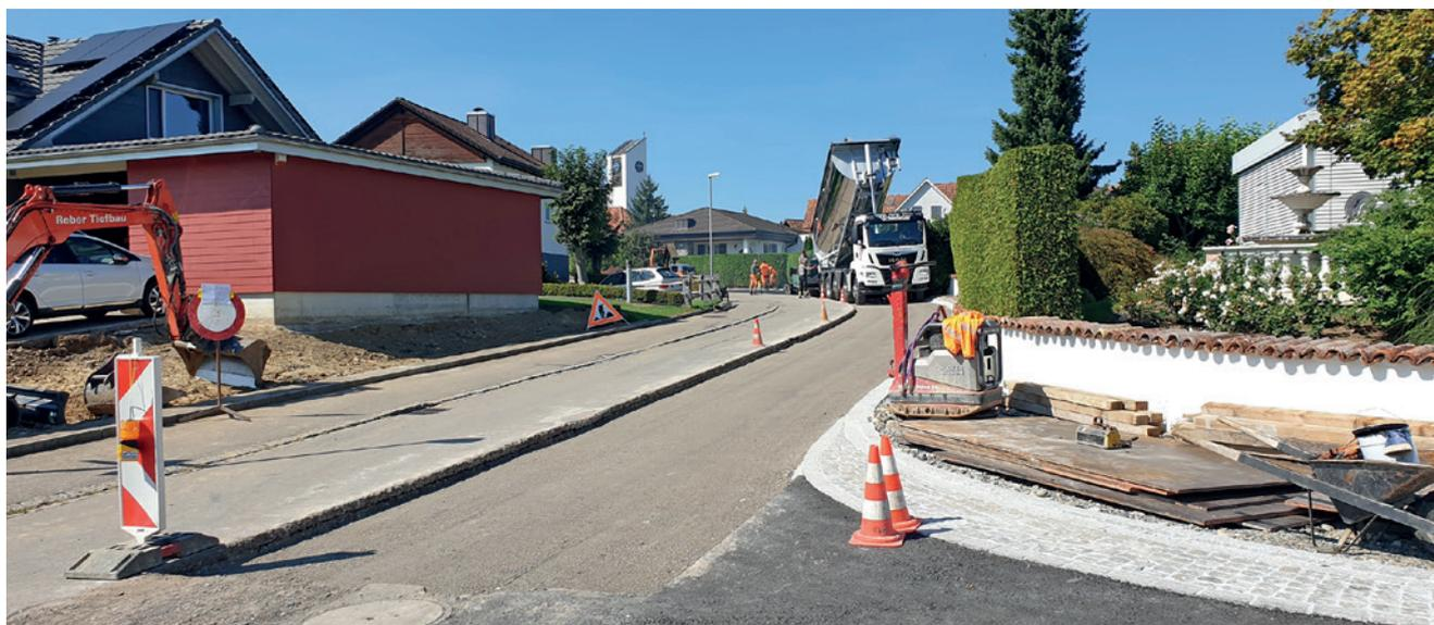
Grosswiesstrasse: Die neue Tragschicht wird eingebaut.
