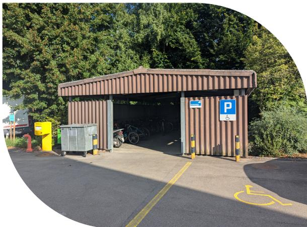
Beim Neubau bleibt das Grundgerüst erhalten, jedoch werden das Dach und die Seitenwände neu eingekleidet. Das Veloparkiersystem sowie die Beleuchtung werden modernisiert. Geplant ist ein doppelstöckiges System, mit welchem zukünftig 88 Veloabstellplätze zur Verfügung stehen.
